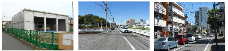
本町出張所消防仮庁舎
