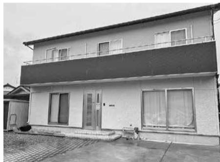
旧耐震基準の住宅は倒壊など大きな被害を受けましたが、すぐ近くにある新耐震基準の住宅（左記の写真）に目立った被害はありませんでした。
