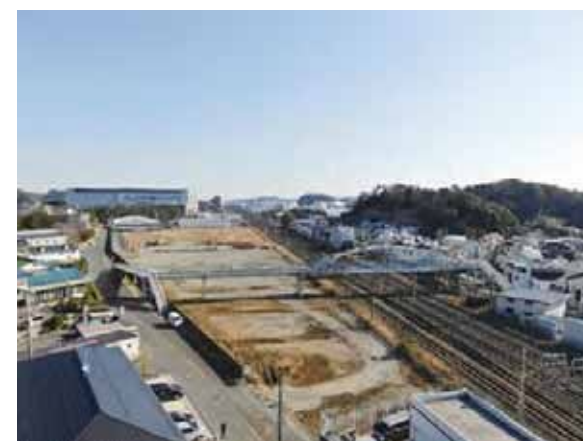
北西側から見た村岡新駅周辺地区
