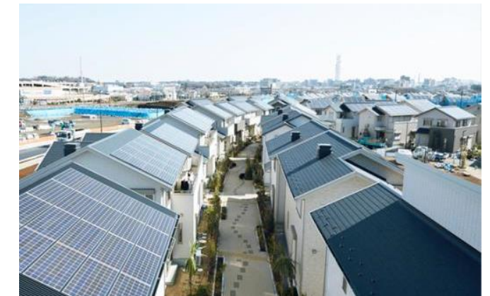
太陽光パネルがならぶ街並み (Fujisawa SST HP より)
